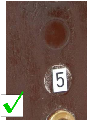
Εικ. 14: OK. Μικρές ανομοιομορφίες της επιφάνειας και του χρωματισμού της
