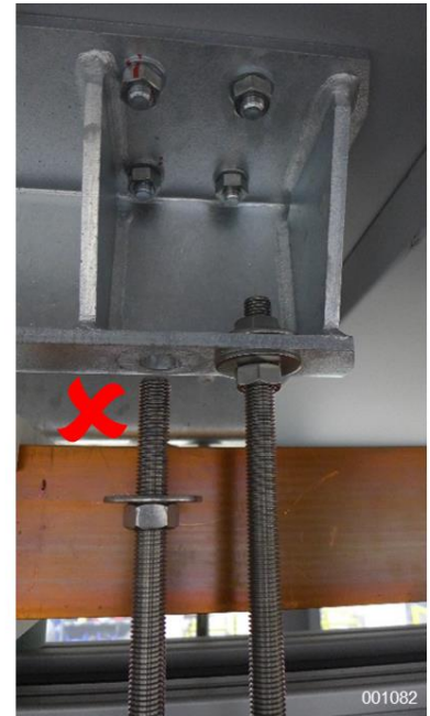
União roscada desapertada
